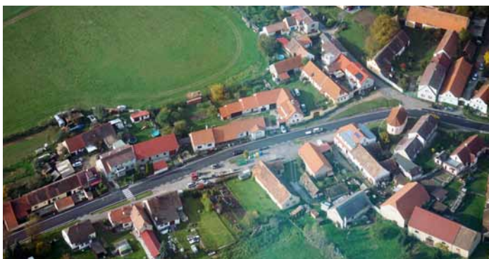
Průtah obcí s novým povrchem vozovky, foto Martin Dolejš
