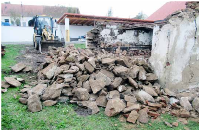
Demolice části budovy čp. 6 – hospodářská část
