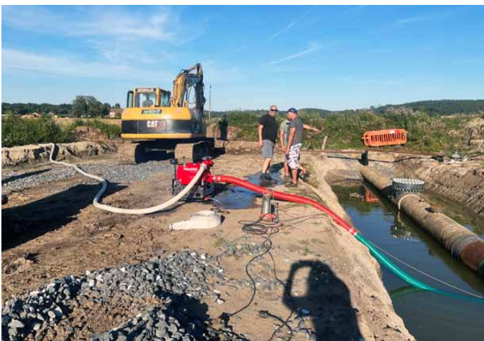
Výměna plynového potrubí
