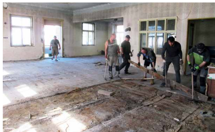
Přípravné práce na rekonstrukci společenského sálu čp. 6 Velká Turná
